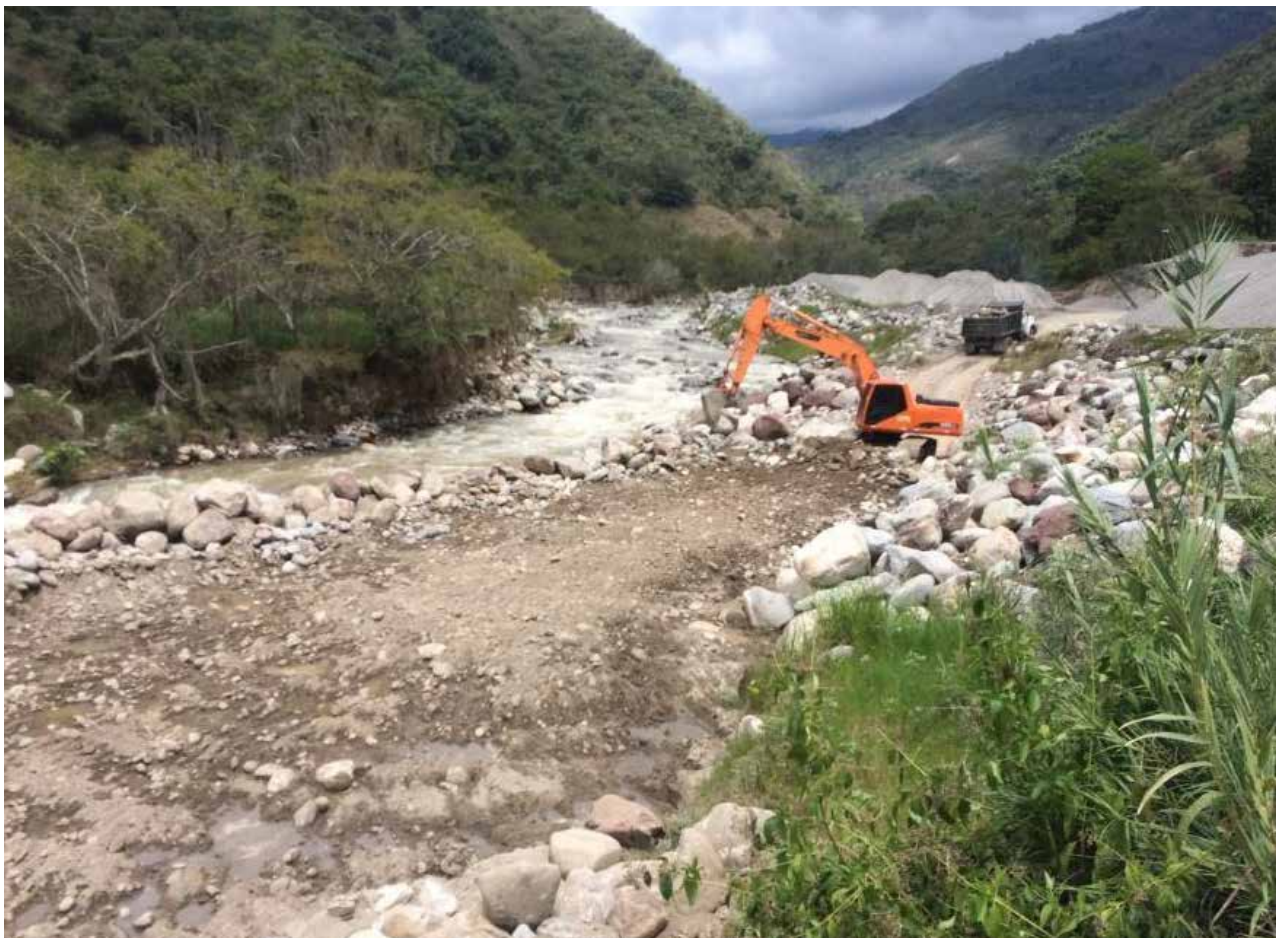
⬇ Figura 30. Acopio de materiales en área segura Fuente: autores
