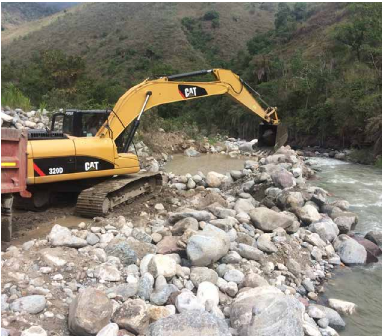
⬇ Figura 32. Excavación de pozo seco Fuente: autores
