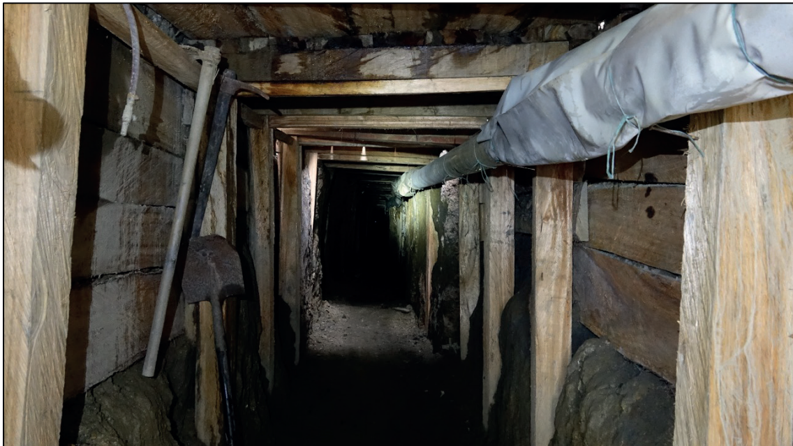
Figura 39: Tunelería con labores de sostenimiento realizadas para la extracción de esmeraldas. Fuente: CDTEC, 2020
